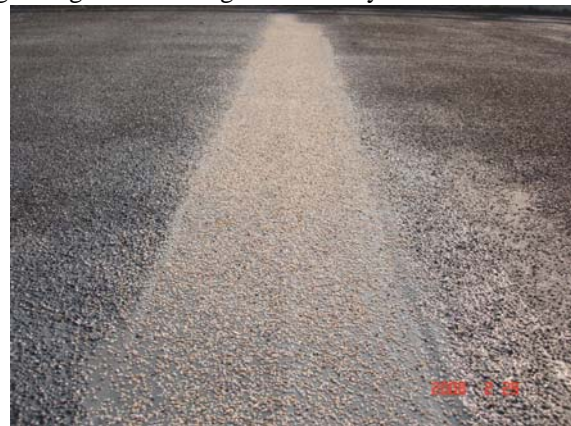
Phun cát hoặc đá xay lên bề mặt Polyurea để tăng độ dính bám với lớp SMA phía trên
