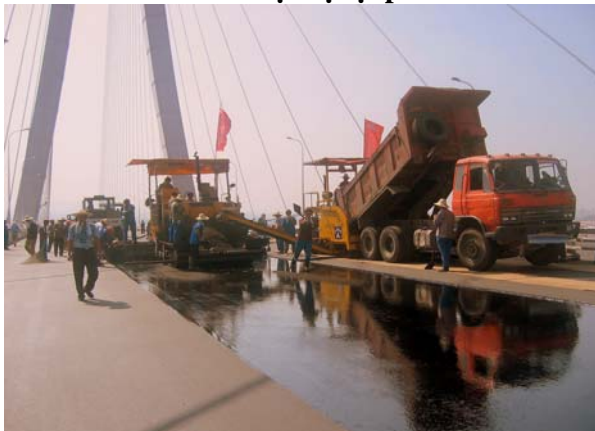
BTN được chuyển vào máy rải thông qua băng chuyền
