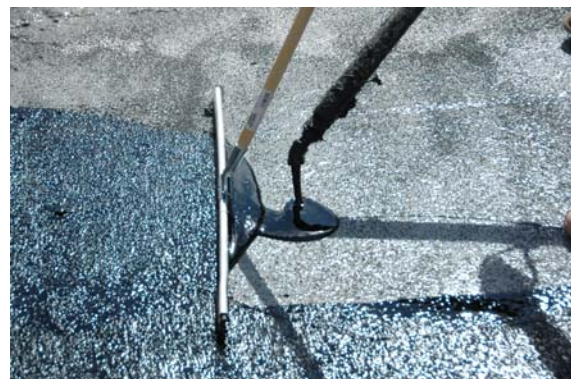
Thi công lớp tack coat bằng nhựa đường cải tiến Pôlime đặc nóng ở trên
