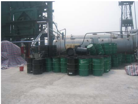
Tập kết vật liệu dính bám tại cầu
