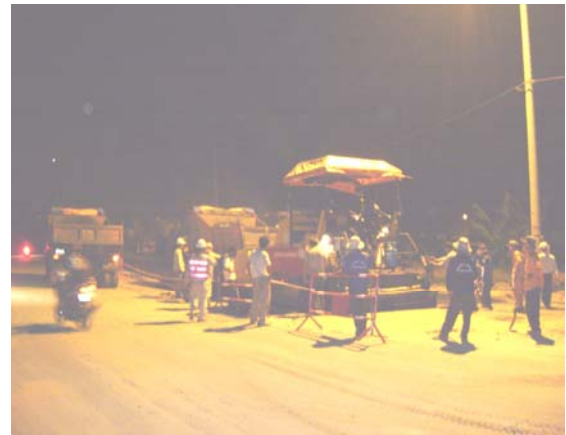
Rào chắn cảnh báo đảm bảo an toàn giao thông trong thời gian rải thử
