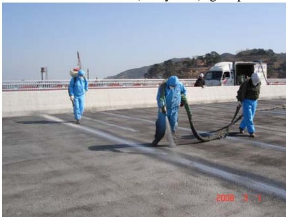
Phun cát hoặc đá xay lên bề mặt Polyurea để tăng độ dính bám với lớp SMA phía trên
