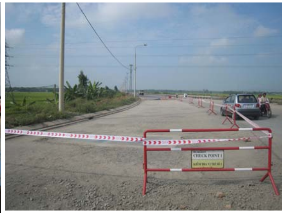
Tại đây tấm được lắp đặt trên đường với cao độ mặt tấm bằng với cao độ mặt đường
