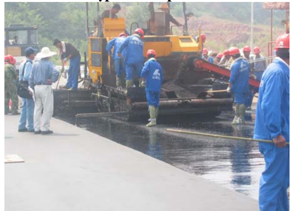
BTN được chuyển vào máy rải thông qua băng chuyền
