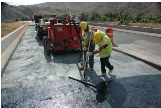
Thi công lớp tack coat bằng nhựa đường cải tiến Pôlime đặc nóng ở trên
