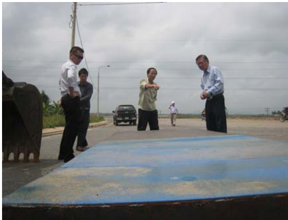
Tấm mẫu đã chuẩn bị được đưa đến đoạn dự kiến thăm thử trên tuyến tỉnh lộ 605
