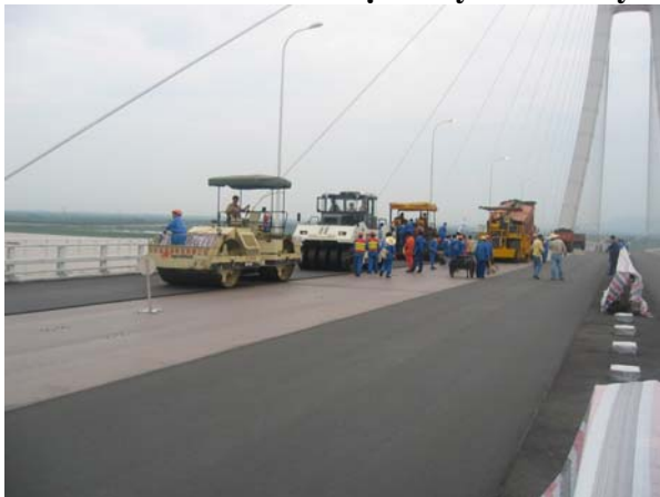
Dây chuyền thấm BTN Epoxy trên cầu
