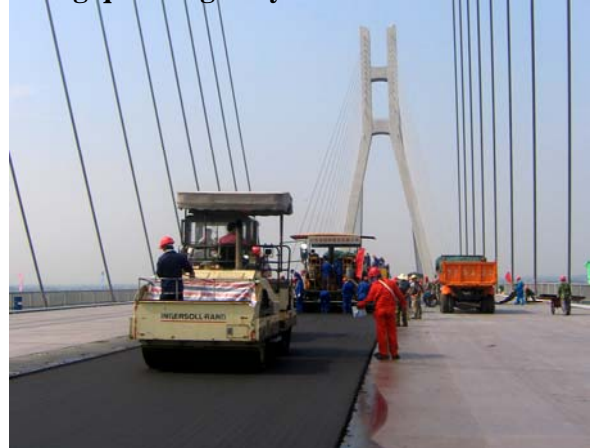
Dây chuyền thấm BTN Epoxy trên cầu
